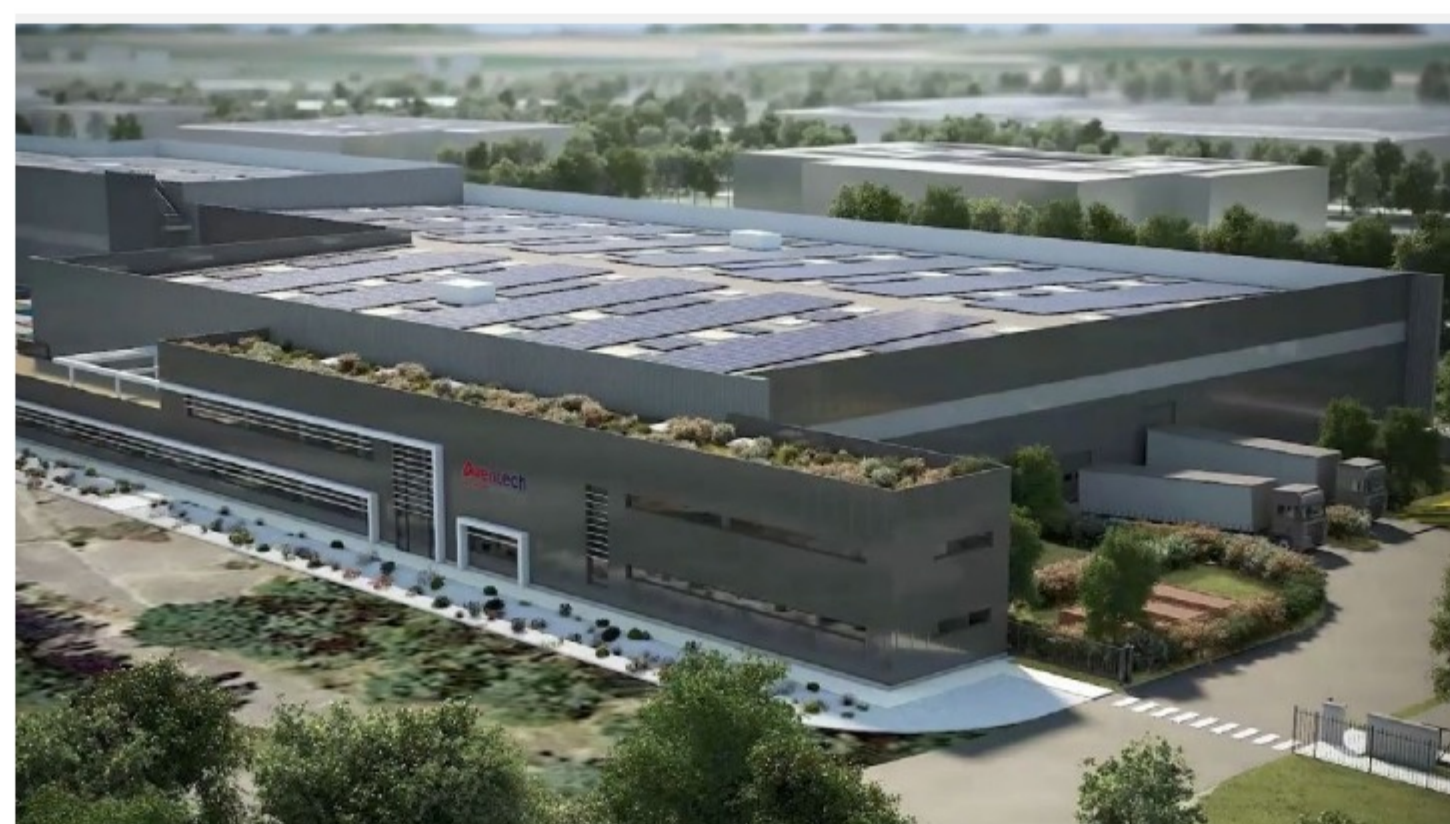
La future usine d'unités de purification de biogaz et de liquéfaction de CO2 à Valence, image Aventech
