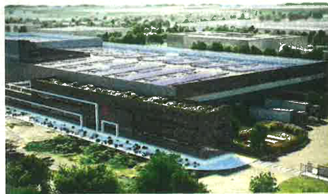
La future usine Aventech de 20 000 m 2 à Rovaltain abritera la nouvelle ligne de production inédite de Prodeval , dédiée à la filière biogaz. Photo Aventech
